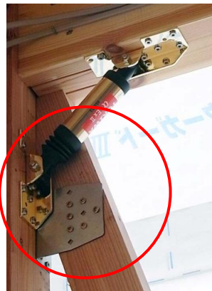
筋かい金物とαダンパーEx II の 併設設置写真
