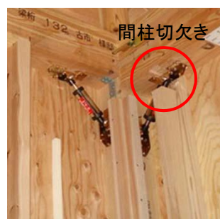
図14 間柱切欠き例
