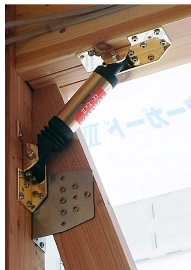
ダンパー・筋かい併設部分
