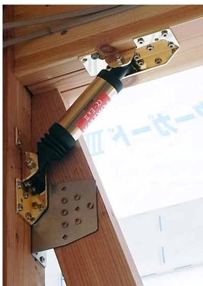
ダンパー・筋かい併設部分 取付参考写真
