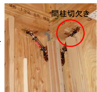
図14 間柱切欠き例
